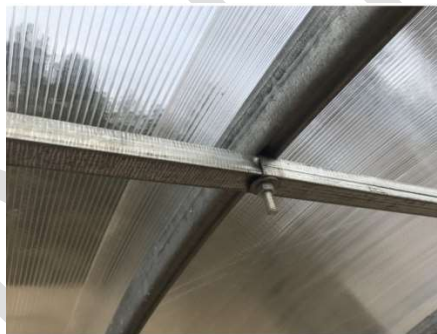
Pav. 10 Templių ir lankų sujungimas
